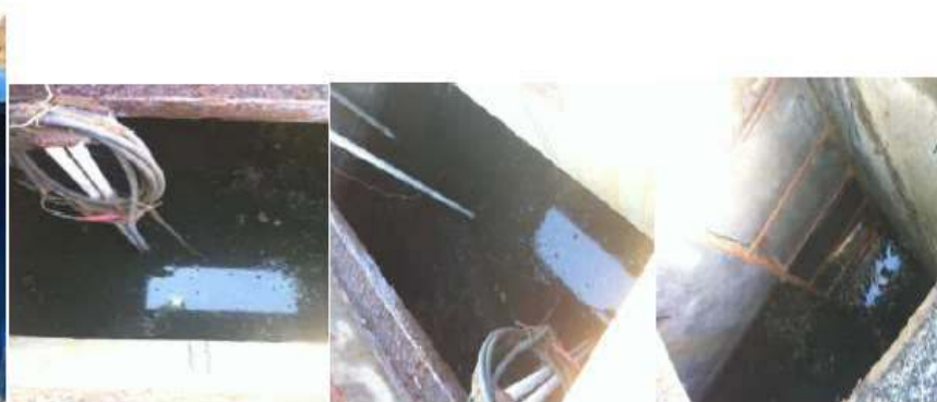
SPAU Arcului – detaliu incinta SPAU
