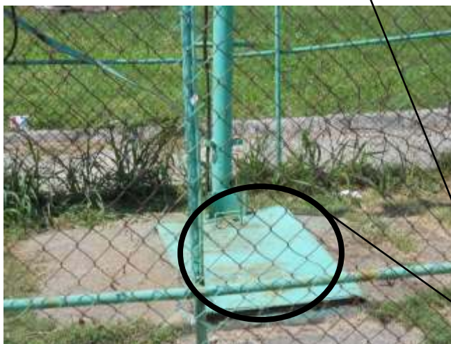
Lipsa minima protectie acces put
