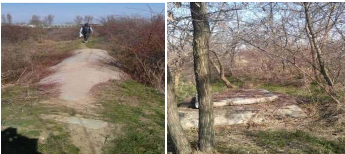
Detaliu tronsoane Colector C1 – trasee impracticabile in interventii/acces dificil al utilajelor
