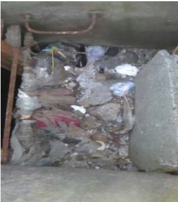
Colector C1 – detaliu interior camin vizitare: lipsa protectie gura vizitare, colmatare deseuri menajare, lipsa scari acces camin
