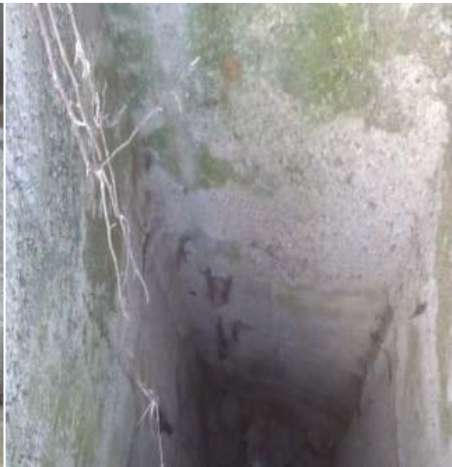
Colector C1 – detaliu interior camin vizitare: lipsa protectie gura vizitare, colmatare deseuri menajare, lipsa scari acces camin
