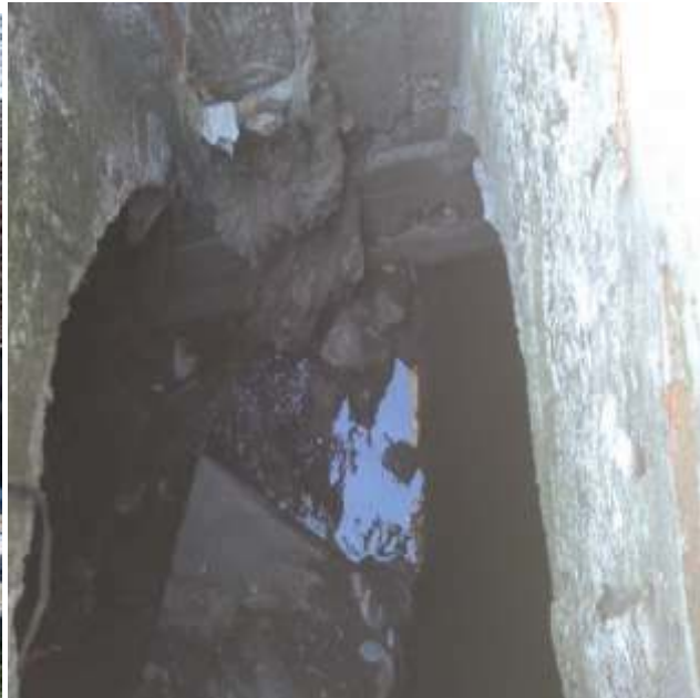
Detaliu camin vizitare colector C1 – stare avansata degradare, lipsa protectie gura vizitare, degradare avansata scari acces interior
