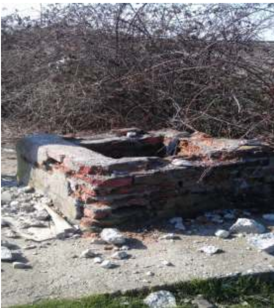
Detaliu camin vizitare colector C1 – stare avansata degradare, lipsa protectie gura vizitare, degradare avansata scari acces interior
