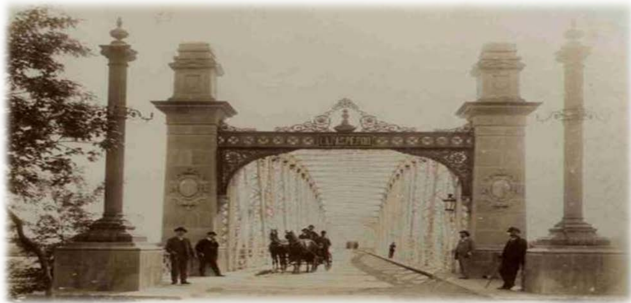
Podul metalic peste Olt, una dintre lucrările efectuate în secolul XIX
