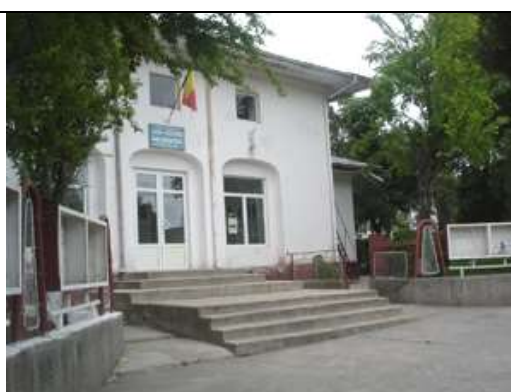
Drăgăneşti Olt - Casa de Cultură
