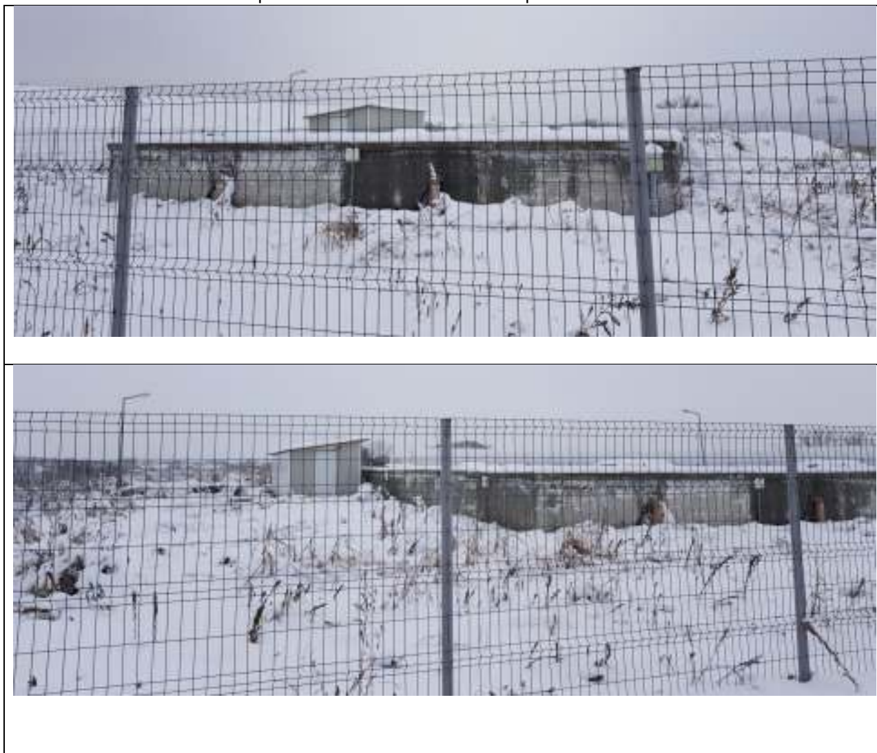
Figura 32 – Stații de epurare existente Izbiceni
