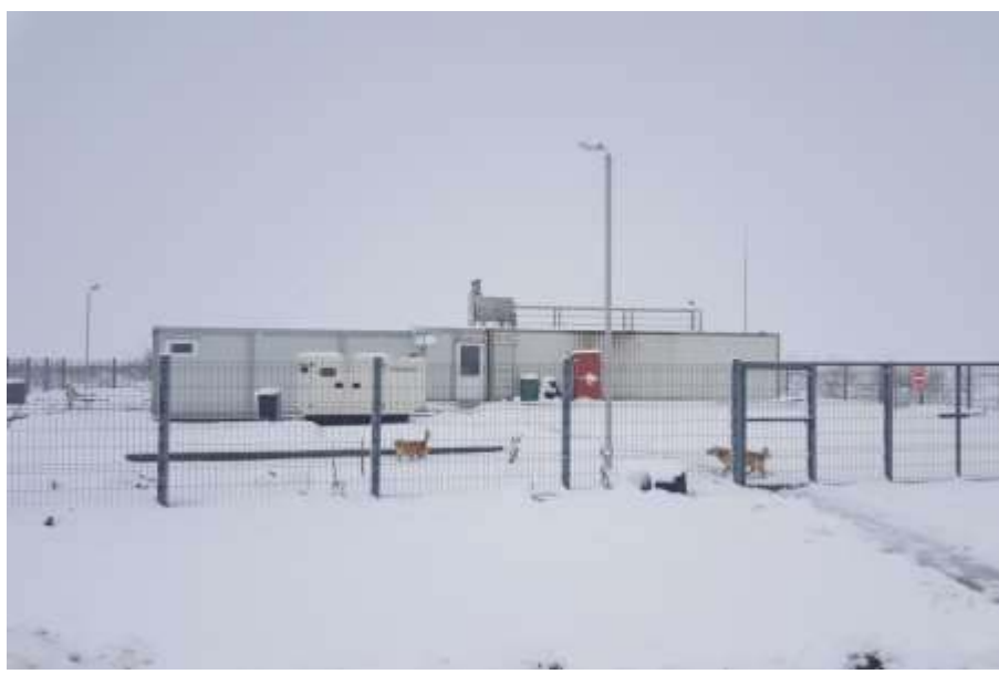
Figura 4 – Stație de epurare existentă Giuvarasti-Sursa de Finantare PNDL
